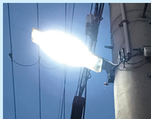
防犯灯・防犯カメラの設置
