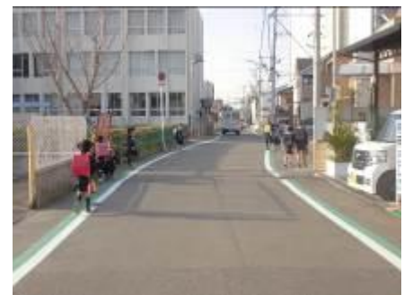
通学路の路肩カラー舗装
