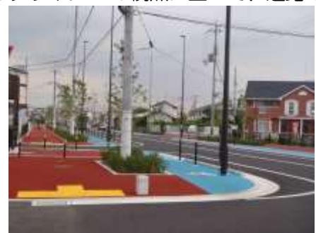
整備後の南海中央線(森地区)の様子
