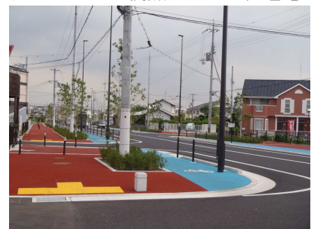
整備後の南海中央線(森地区)
